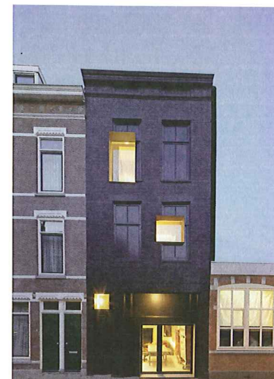
Op enkele plaatsen prikken de nieuwe transparante vensters door de historische gevel naar buiten.
